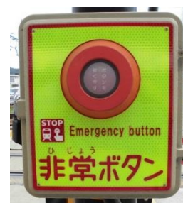
踏切支障報知装置
