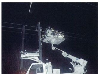
工事実施時の写真
